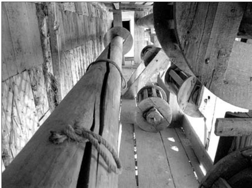
Машинерия на сцене Театра Гонзаги в процессе реставрации (восточная галерея)
