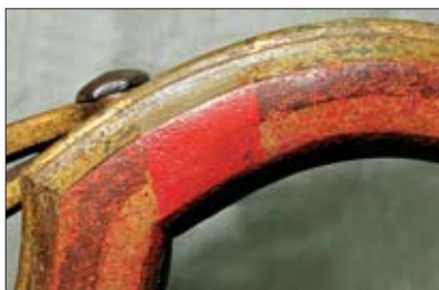
46. Фрагмент металлической дрожины кареты Екатерины II после реставрации: раскрыта авторская позолота и окраска по металлу, оставлен фрагмент с поздними «записями».
