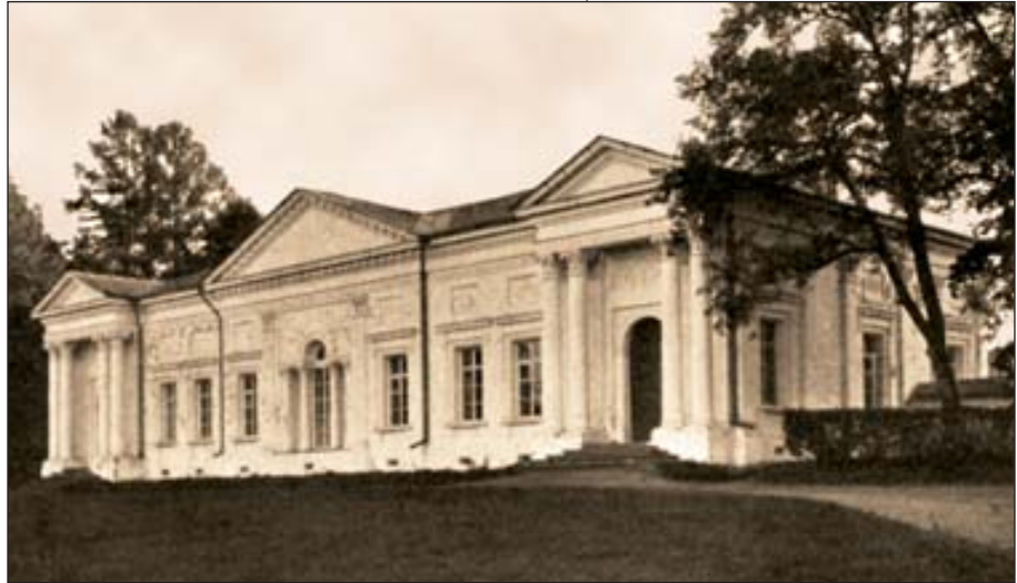
Белый домик в Никольском-Урюпине. Главный фасад. Фото начала XX в.
