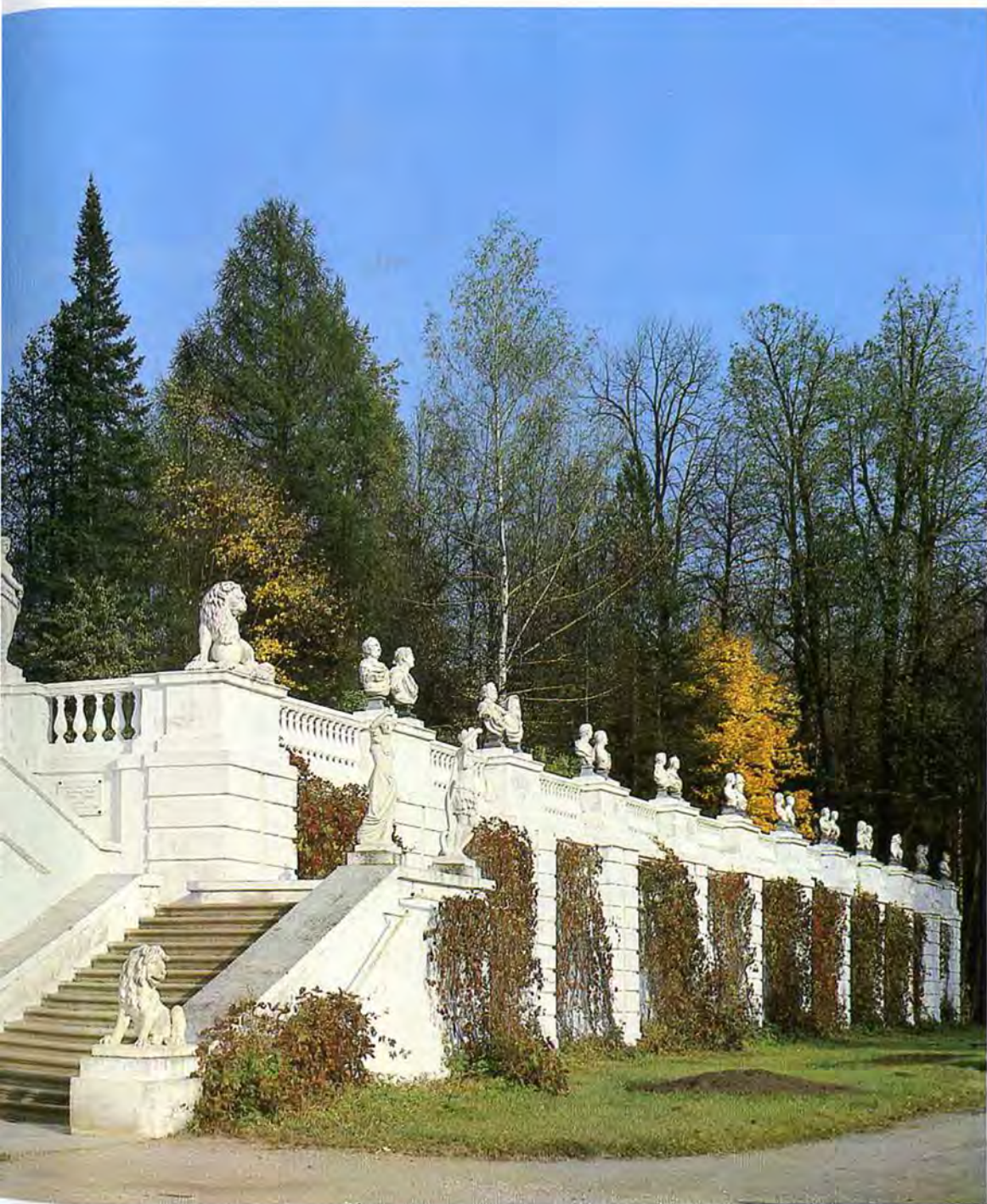
12. Подпорная стена нижней террасы Supporting wall of the Lower Terrace
